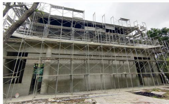
三清殿外觀建設進度
