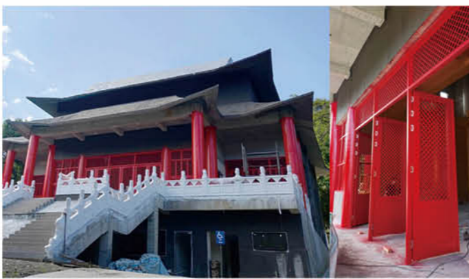
三清殿外觀建設進度
